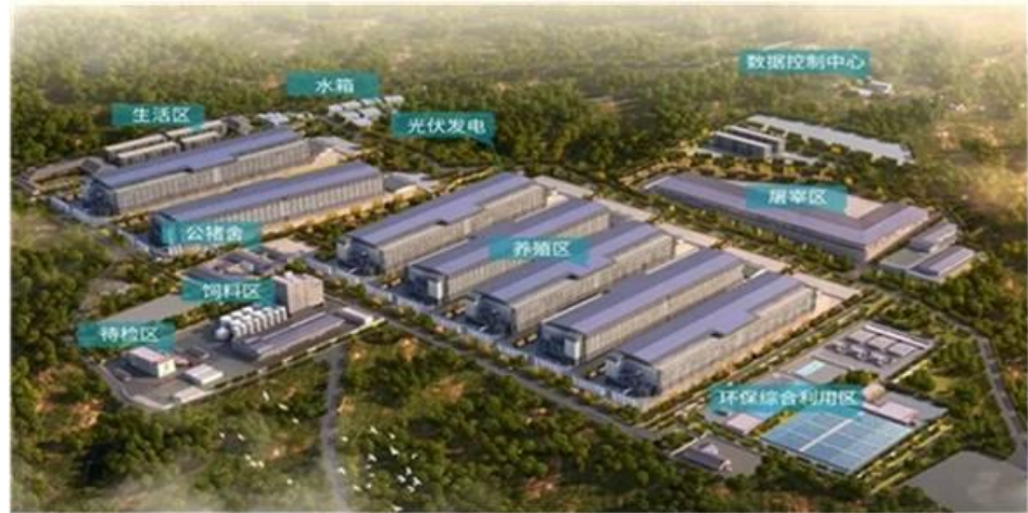
图 27: 德昌巨星 100 万头智慧养猪园区项目
