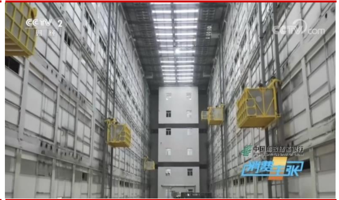
图 2 楼层之间由电梯转运猪只
