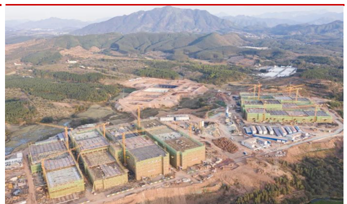
图 4 正在建设中的船塘现代农业综合体项目
