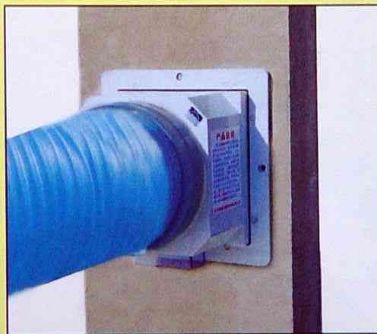
排风口已接上排油烟机软管
