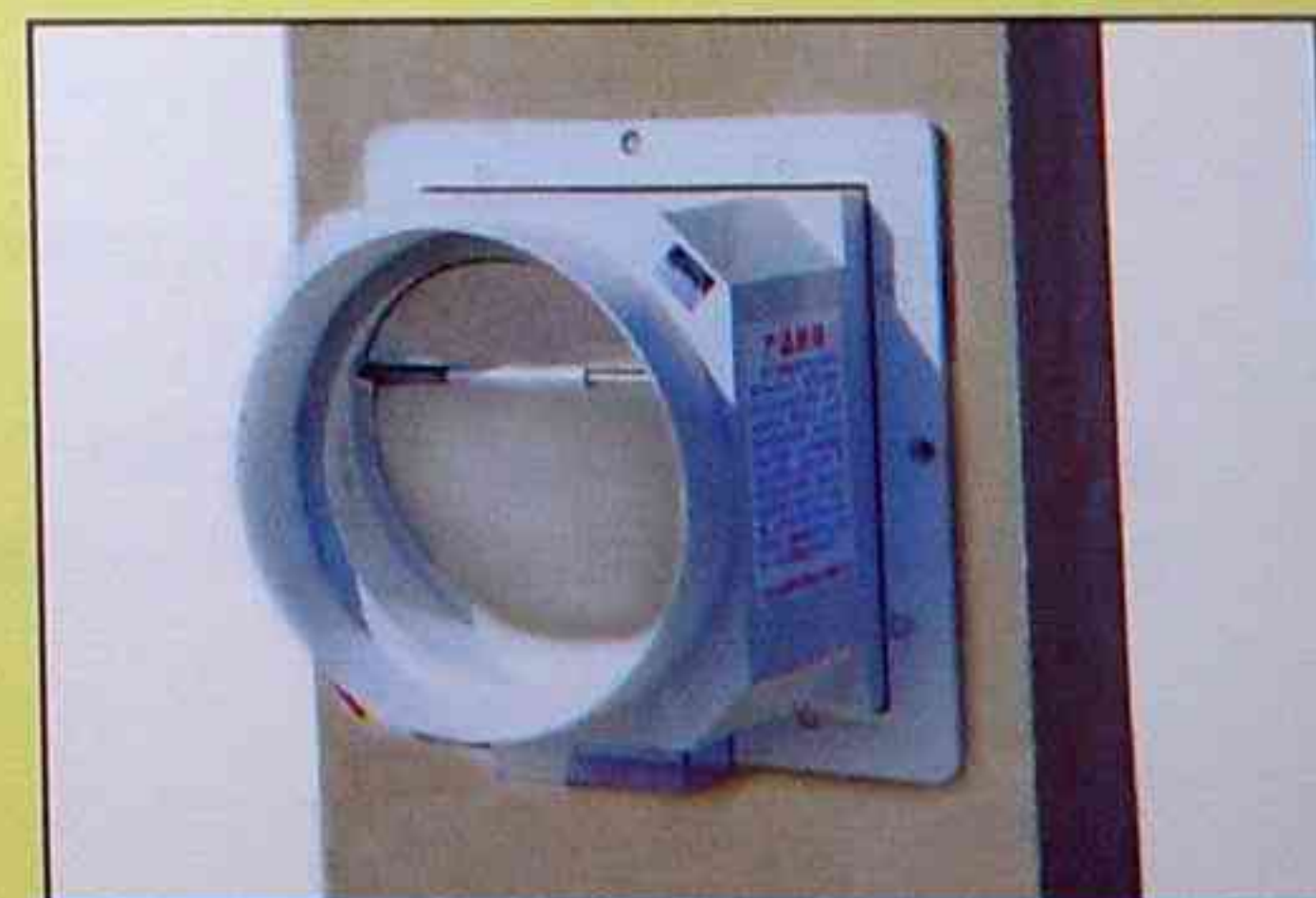
排风口安装就位
