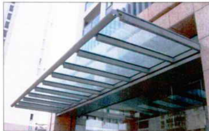
钢雨篷七(端部有排水管)
