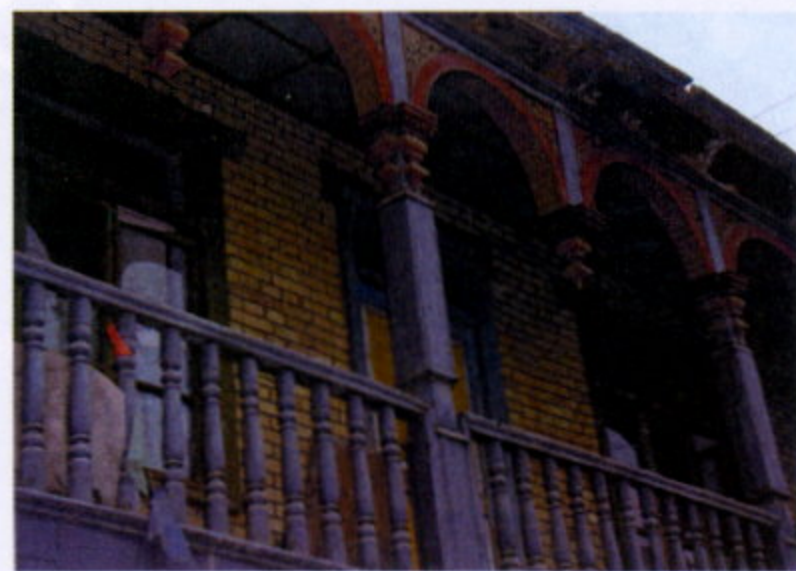
图 14 喀什地区住宅二楼廊柱
