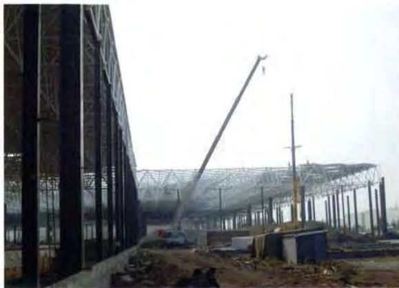
钢框轻型屋面板安装现场
