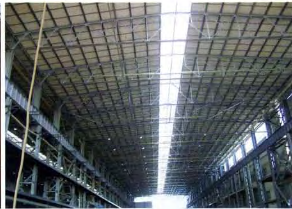
汽车零部件冲压车间钢框轻型屋面板
