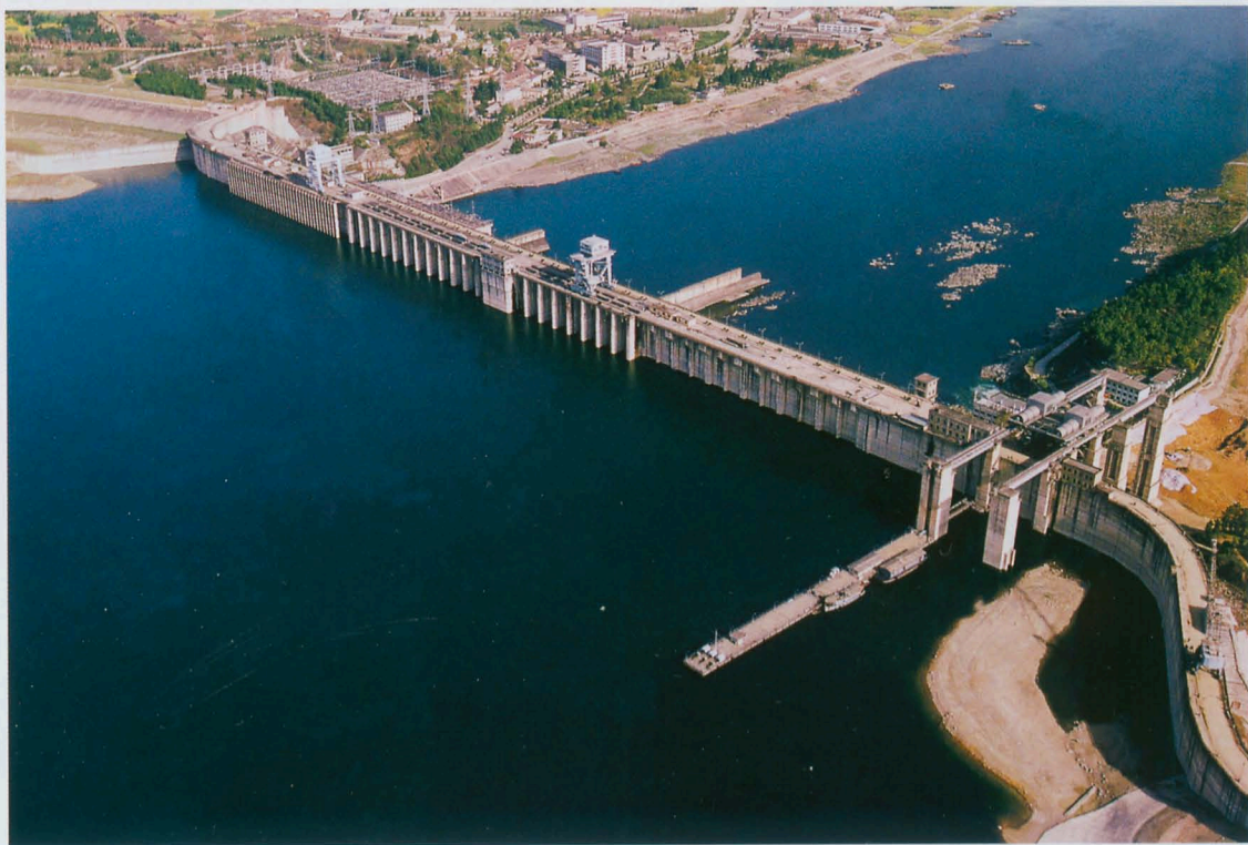
丹江口水利枢纽工程位于湖北省丹江口市，汉江与其支流丹江汇合口下游800米处。初期工程于1958年兴建，1973年建成，是汉江上最大的水利工程。它由挡水建筑物、发电建筑物、通航建筑物、引水建筑物等组成。大坝长1141米，最大坝高97米，电站为坝后式厂房，装机容量为100万千瓦。摄影/刘铁军
