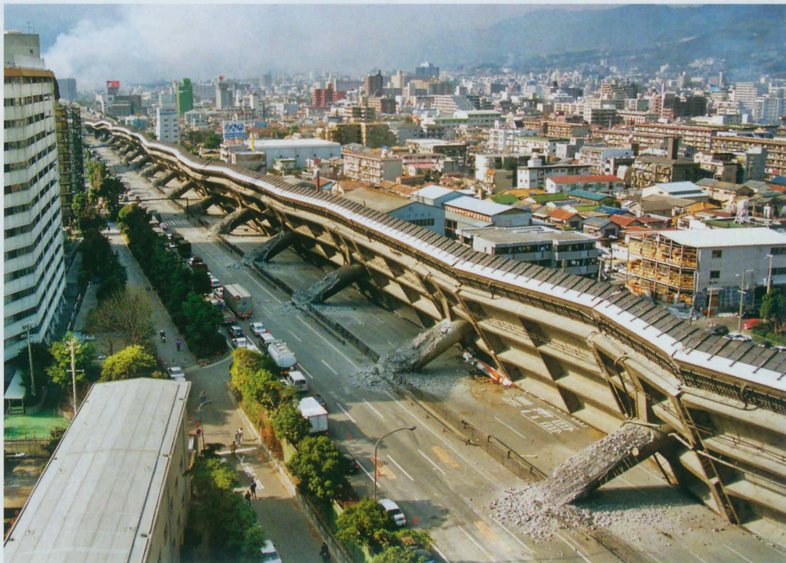
1995年1月17日，在日本阪神大地震（7.2级）中倒塌的高速公路 摄影/RTR
