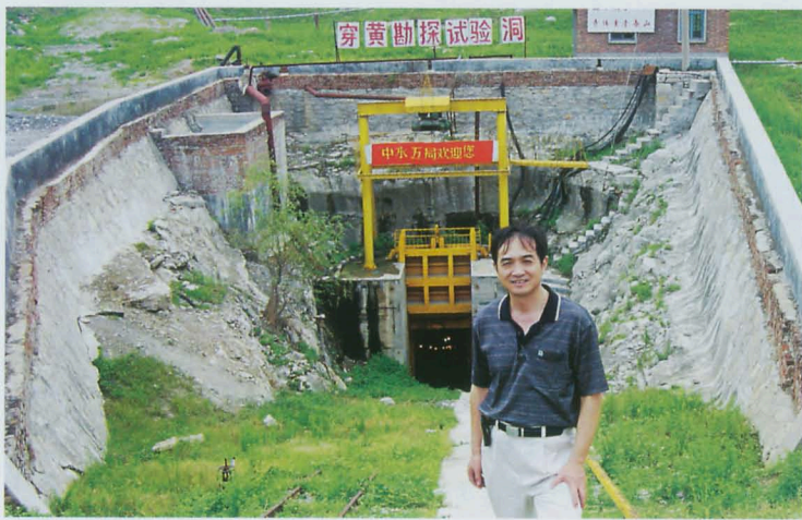
张少华在考察南水北调东线穿黄隧洞。东线穿黄隧洞位于山东东平县解山和东阿县位山之间形成的黄河天然卡口处。穿黄隧洞于1986年开工,1988年完工,1999年进行过全面加固。
