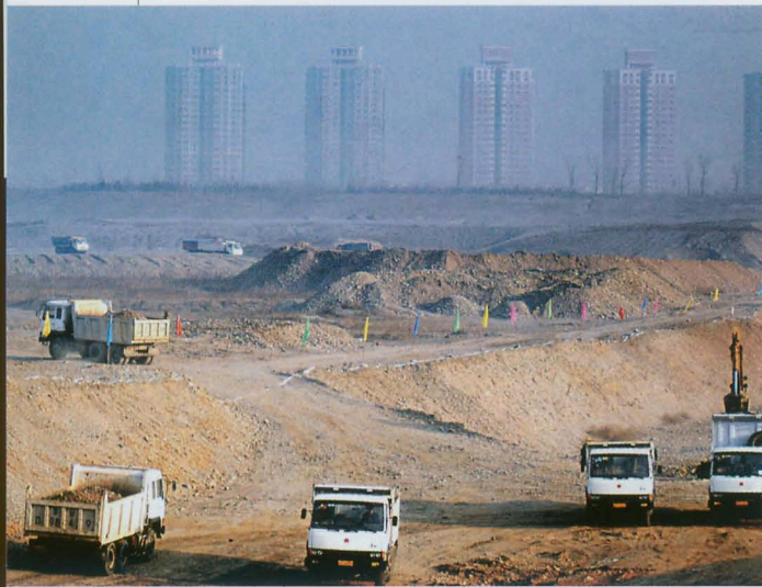
南水北调中线京石段应急供水工程南起河北省石家庄，北至北京团城湖，是结合向北京应急供水优先安排的工程，为确保2007年应急供水进京、2008年黄河水调入北京奠定了基础。图为京石段建设工地。 摄影/Zhangyu
